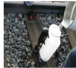
Bild 5 und Bild 6 Harz-Härtergemisch umtopfen
