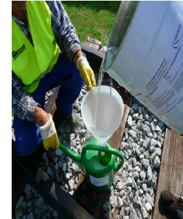
Bild 5 und Bild 6 Harz-Härtergemisch umtopfen
