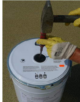
Bild 2 Deckeleinsatz mit Härterkomponente durchstoßen.
