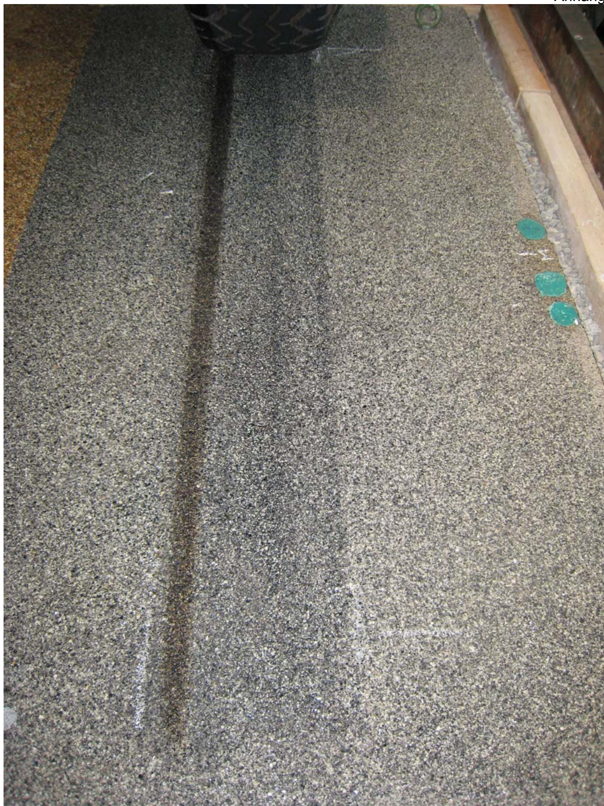
Bild 5: Zustand der Deckschicht 1/3mm nach Abschluss der Phase 6. Der dunkle Streifen ist die Folge eines Lecks im Bremssystem der Versuchseinrichtung. Die Bremsflüssigkeit DOT4 wurde vom Reifen in die Deckschicht eingearbeitet. Schäden in Form von Ausbrüchen waren zu diesem Zeitpunkt (nach 50.000 LW) nicht erkennbar.
